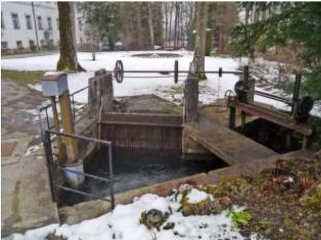
Der Zulauf zum E-Werk befindet sich hinter dem Gitter in der Mitte. Von hier aus fließt das Wasser verrohrt in das 90 Meter östlich gelegene E-Werk. Das Gefälle beträgt ca. 8 Meter.
