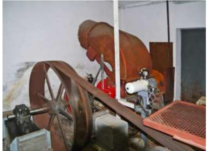
Oben: Die Turbine, mit dem Keilriemen zum Generator.
