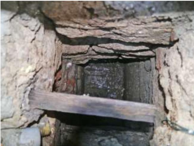
Blick senkrecht nach unten in den Feuerkanal in der Hofmark 22. Der Kanal verläuft hier südlich des Hauses, unter der Terrasse. Die Öffnung ist sehr klein und das Wasser läuft in drei Meter Tiefe. Eine Löschwasserförderung ist unter diesen Bedingungen nur schwer vorstellbar. Der Kanal diente also bis heute eher der Entsorgung.
