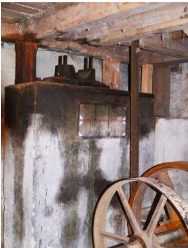
Links: Das Fundament des 1896 neu erbauten Wasserrades, oben ist das Lager der Achse zu sehen.
