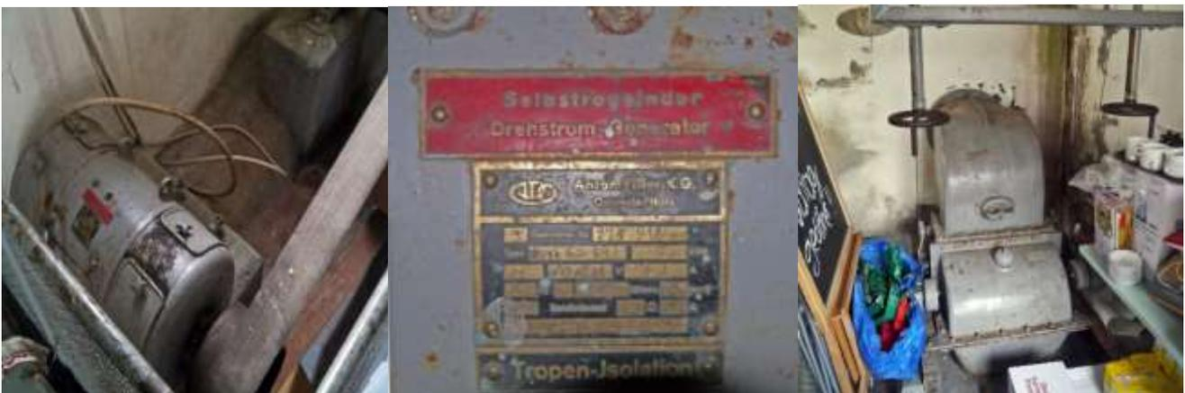
Der heute eigebaute Generator der Firma Anton Piller, Baujahr 1962. Mitte: das Typenschild des Drehstromgenerators. Die Anlage ist seit Jahren nicht mehr im Betrieb.
