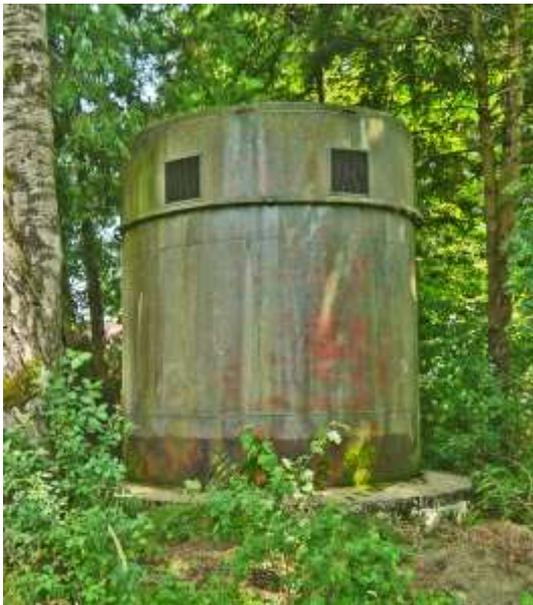
Oben: Der Ausgleichsturm an der Tannenstraße. Er sorgt für einen gleichmäßigen Wasserdruck in der Rohrleitung.
