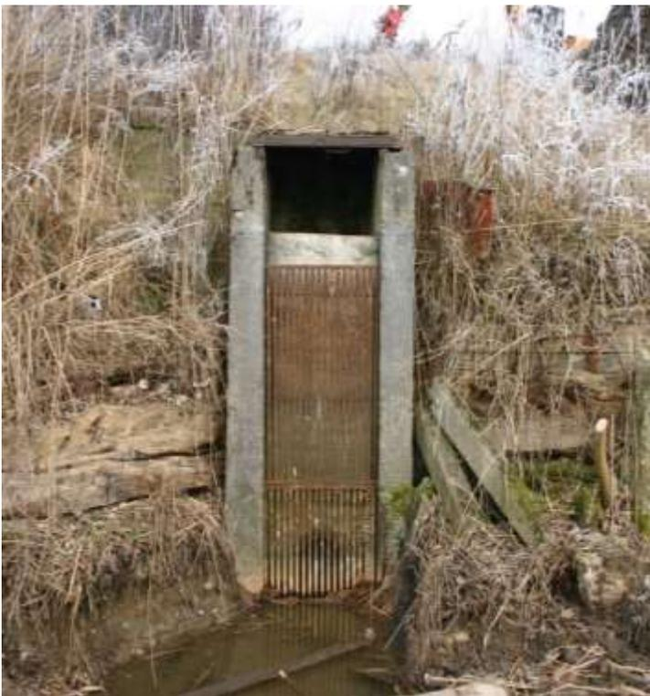
Der Auslauf des Metzger-Weiher, im Norden Richtung des ehemaligen Gattinger Kellers. Dieser begehbare Kanal musste durch die mehrere Meter hohe Tuffbarriere geschlagen werden, er endete nördlich des Gattinger Kellers.
